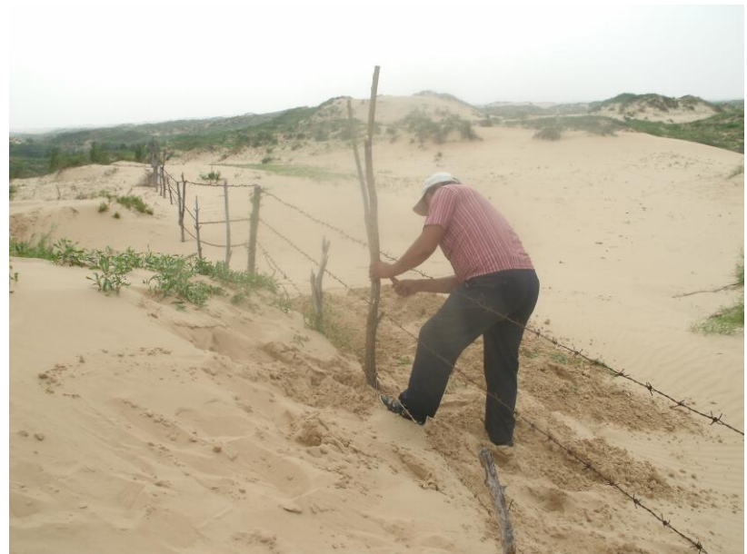
依然として移動砂丘が隣接するため、柵の崩壊は激しく、日常的な保守管理が欠かせません。
